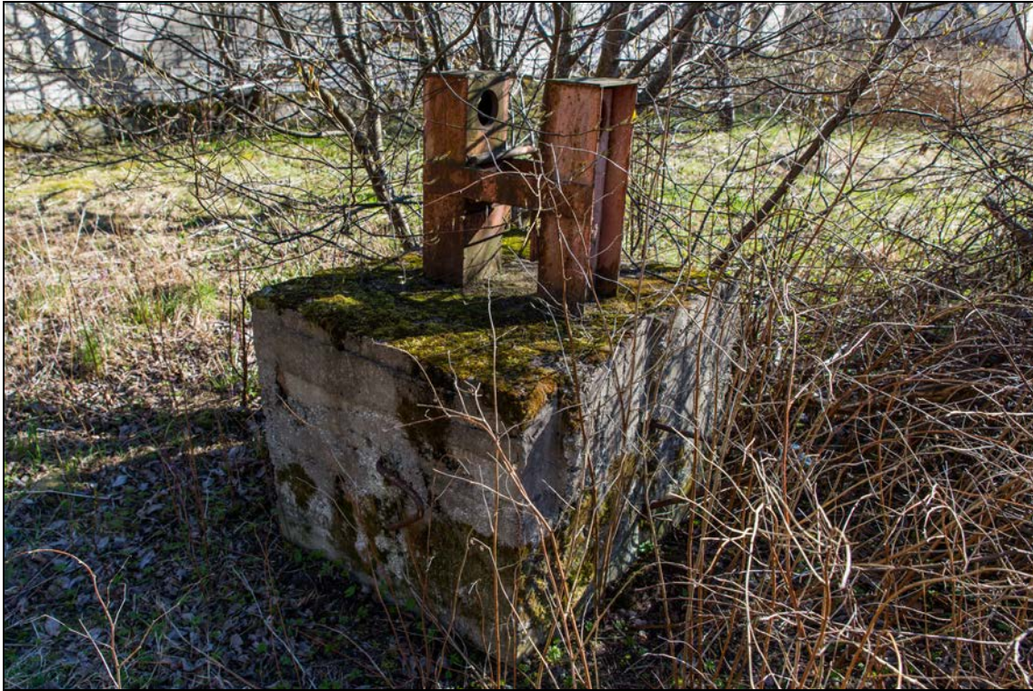
Foto 12 (1532). Turbuneeme kordon. Peahoone [1] ees on massiivne antennimasti alus. Foto Mart Mõniste 24.04.2014.
