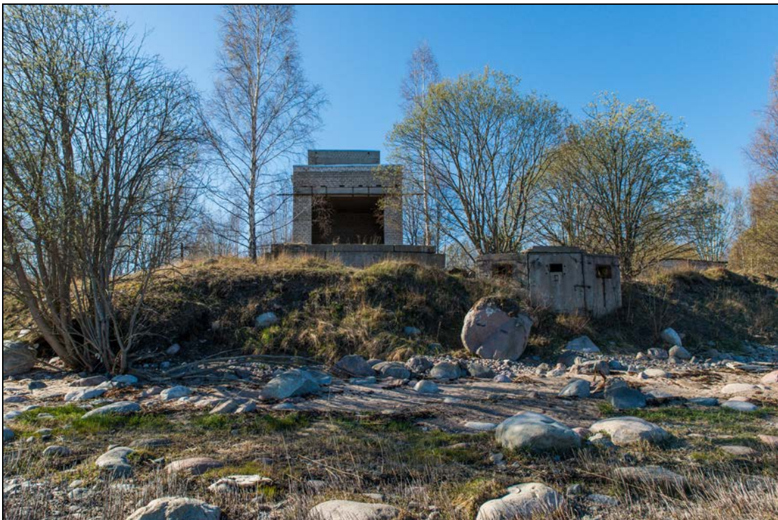
Foto 31 (1470). Turbuneeme kordon. Tehnilise vaatluse post [5]. Otse prožektoriplatvormi servas on kaitsekraav ja monteeritav dott [6]. Foto Mart Mõniste 24.04.2014.
