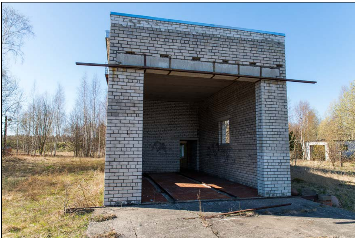
Foto 26 (1450). Turbuneeme kordon. Tehnilise vaatluse post [5]. Foto Mart Mõniste 24.04.2014.
