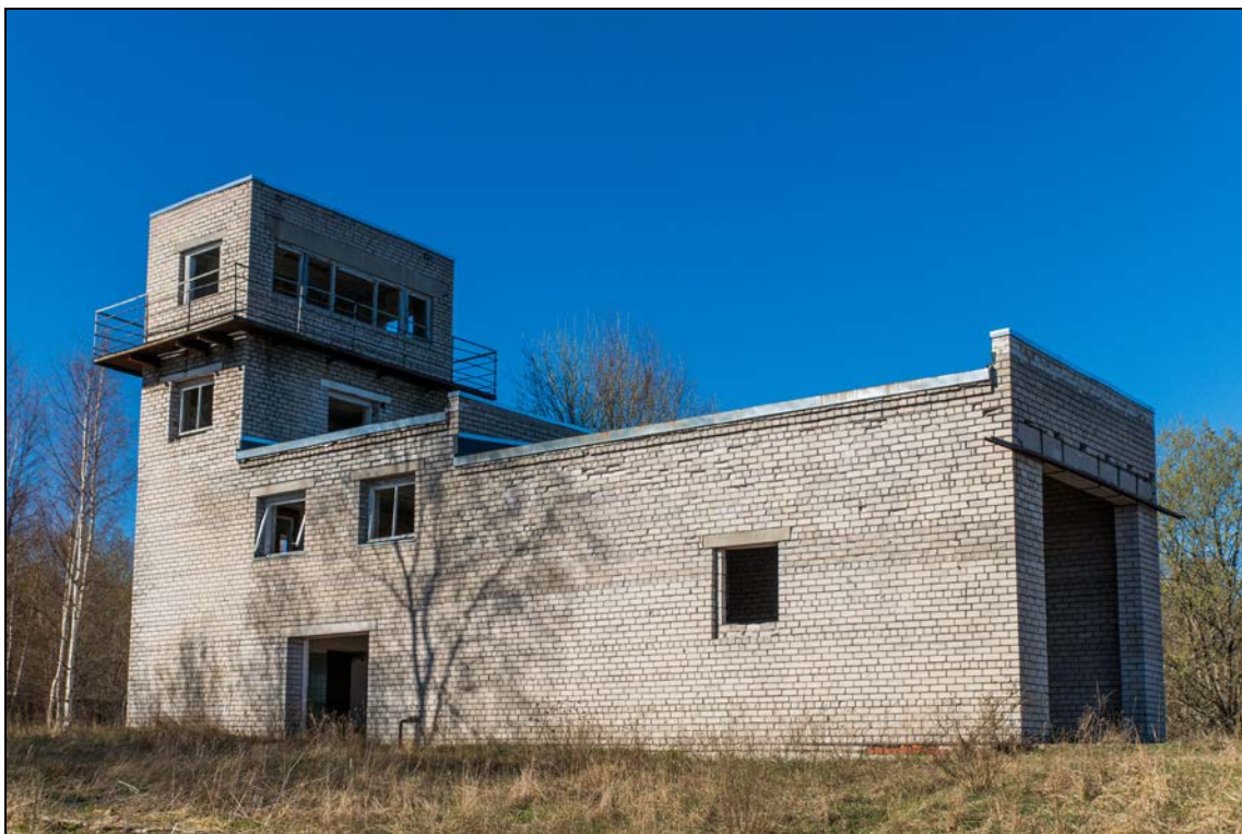
Foto 25 (1467). Turbuneeme kordon. Tehnilise vaatluse post [5]. Foto Mart Mõniste 24.04.2014.
