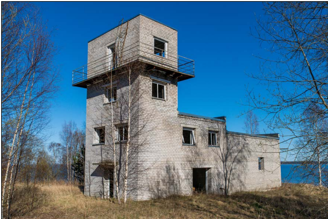
Foto 24 (1499). Turbuneeme kordon. Tehnilise vaatluse post [5]. Foto Mart Mõniste 24.04.2014.
